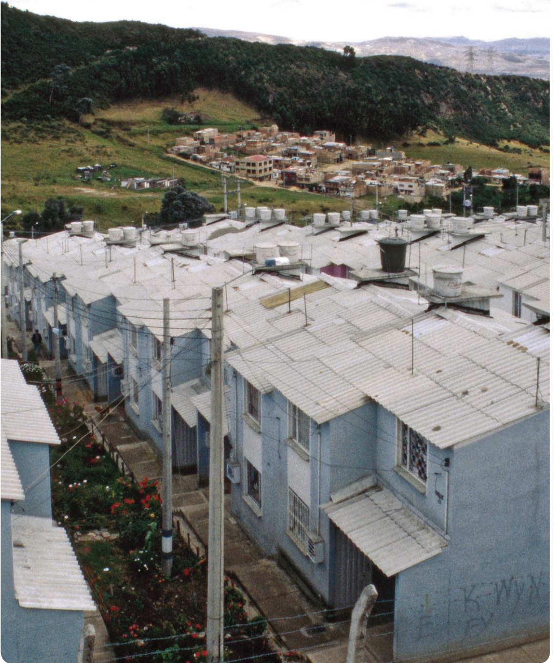
Barrio construido por el Programa de Vivienda de la Alcaldía Mayor de Bogotá. Foto: Archivo Alcaldía Mayor de Bogotá.
