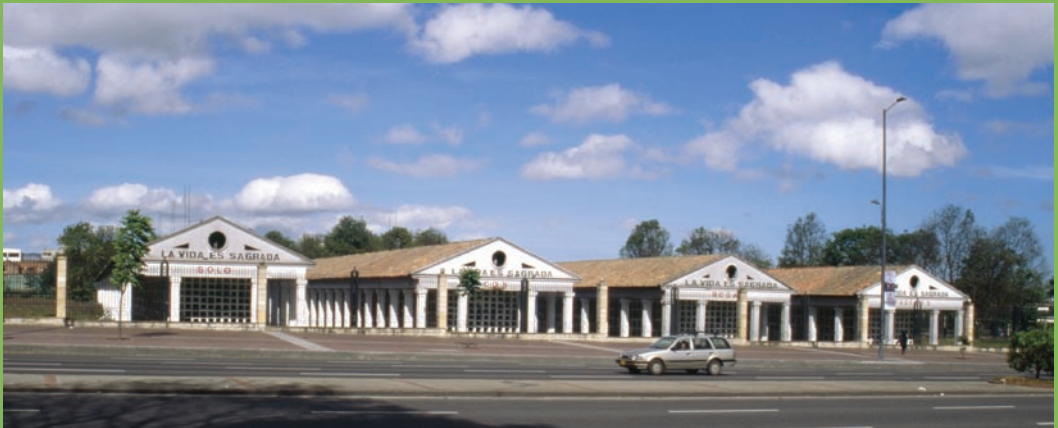
Galerías del Globo B del Cementerio Central con el lema "La vida es sagrada", 2006. Foto: Luis Carlos Colón.
