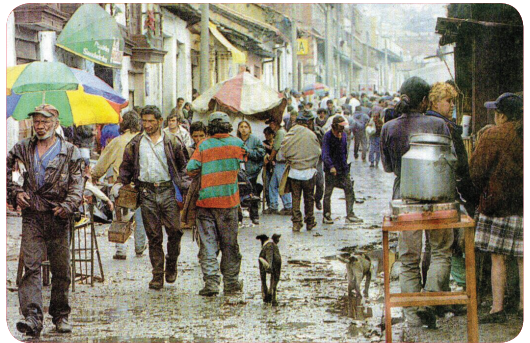
“El Cartucho” antes de su demolición. Foto: Colección MdB.
