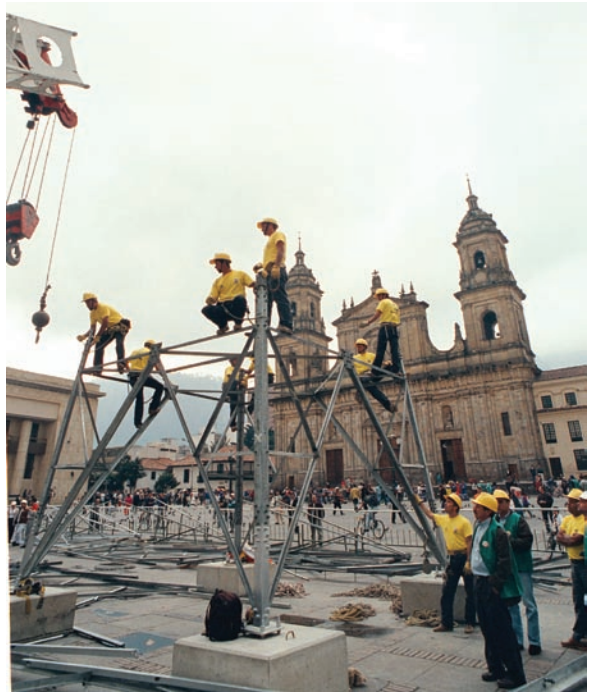
Construcción de una torre de energía en la Plaza de Bolívar como símbolo de resistencia civil frente a los atentados, 2002. Foto: Cortesía Periódico El Tiempo .
